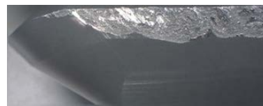
Exemple de fissuration thermique
